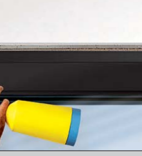
So einfach geht's: Zwischenraum befeuchten ...
