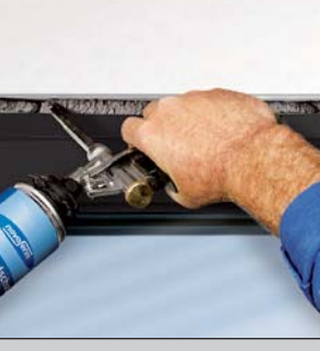
... mit Brandschutzschaum ausfüllen ...
