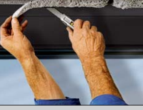
... nach dem Trocknen über- stehenden Schaum entfernen ...
